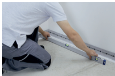
1. Ocenić przydatność i stan wyrównania podłoża.
