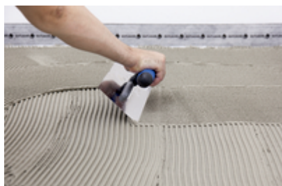
4. Zaprawę klejową nałożyć na podłoża pacą o wysokości zęba 6 mm,...
