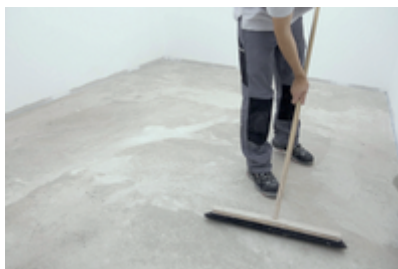
2. Oczyszczyć i zagruntować podłoża
