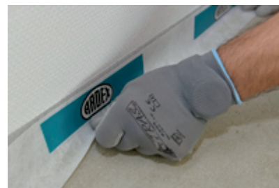
3. Taśmę izolacji brzegowej ARDEX TP 50 wkleić na połączeniu ściana/podłoga i przejść instalacji.
