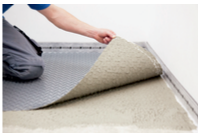
5. Następnie wkleić przyciętą matę ARDEX FLEXBONE® częścią kaszerowaną filizeliną w świeżą warstwę zaprawy klejowej...
