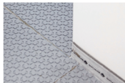
9. ... obszar połączenia przykryć dostępną w handlu taśmą maskującą o odpowiedniej szerokości. W trakcie układania okładziny nad matą ARDEX FLEXBONE® tworzy się szczeliny graniczne do podziału dużych powierzchni pokrycia.
